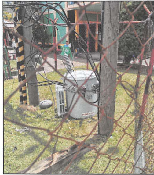
Cambio de Transformadores Cp. Támara
