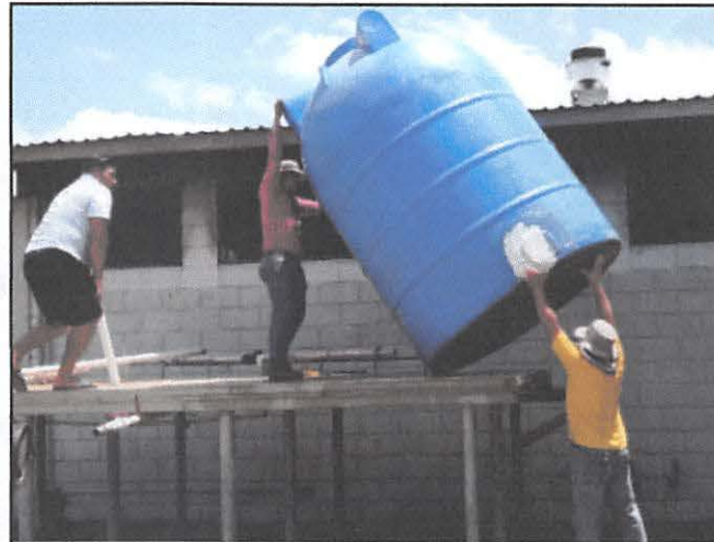
Cambio de línea de conducción de agua potable principal, instalación de tanque adicional para cocina, CP. Siria
