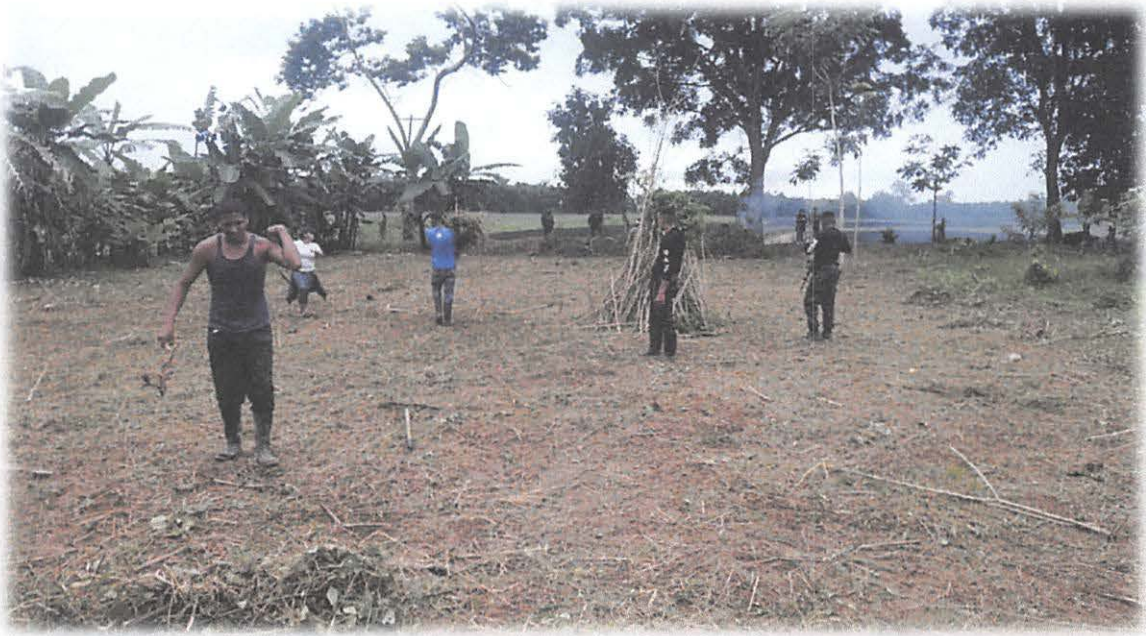
Limpieza de Terreno, El Porvenir, Atlántida
