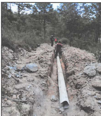
Cambio de línea de conducción de agua potable principal, instalación de tanque adicional para cocina, CP. Siria
