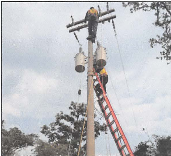
Cambio de Transformador CP. Siria
