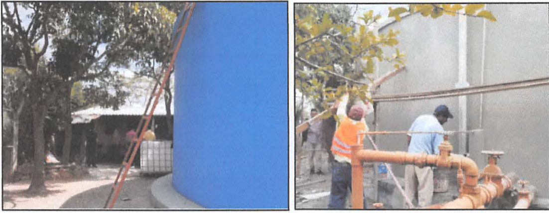
Reparación de Tanque Principal y Válvulas CPN Támara
