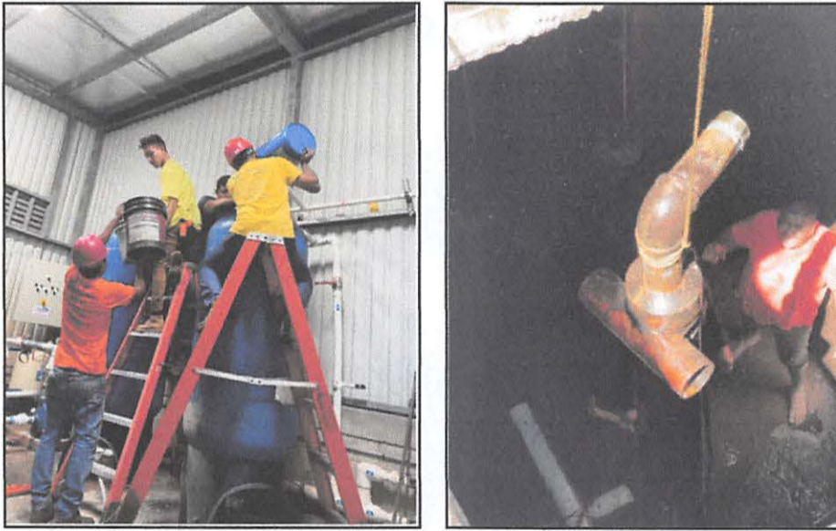
Reparación de Sistema de Bombeo y Cárcamo de Captación CP. Moroceli
